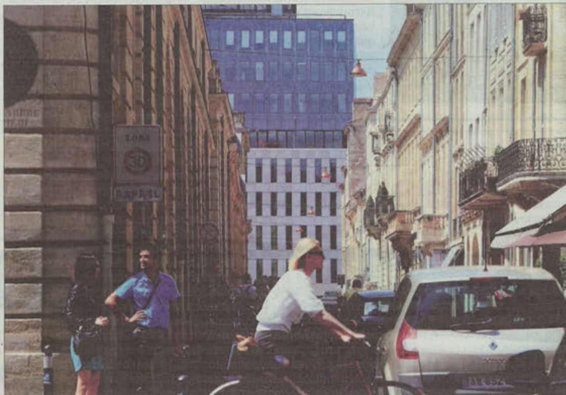
1 500 mètres carrés de panneaux photovoltaïques sont disposés sur le toit du bâtiment
